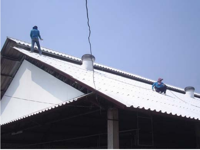
ภาพตัวอย่าง : การติดตั้งฉนวนเคลือบสะท้อนความร้อน Max – Kool หน่วยงาน “ฟาร์มปศุสัตว์ทั่วไป 1”
